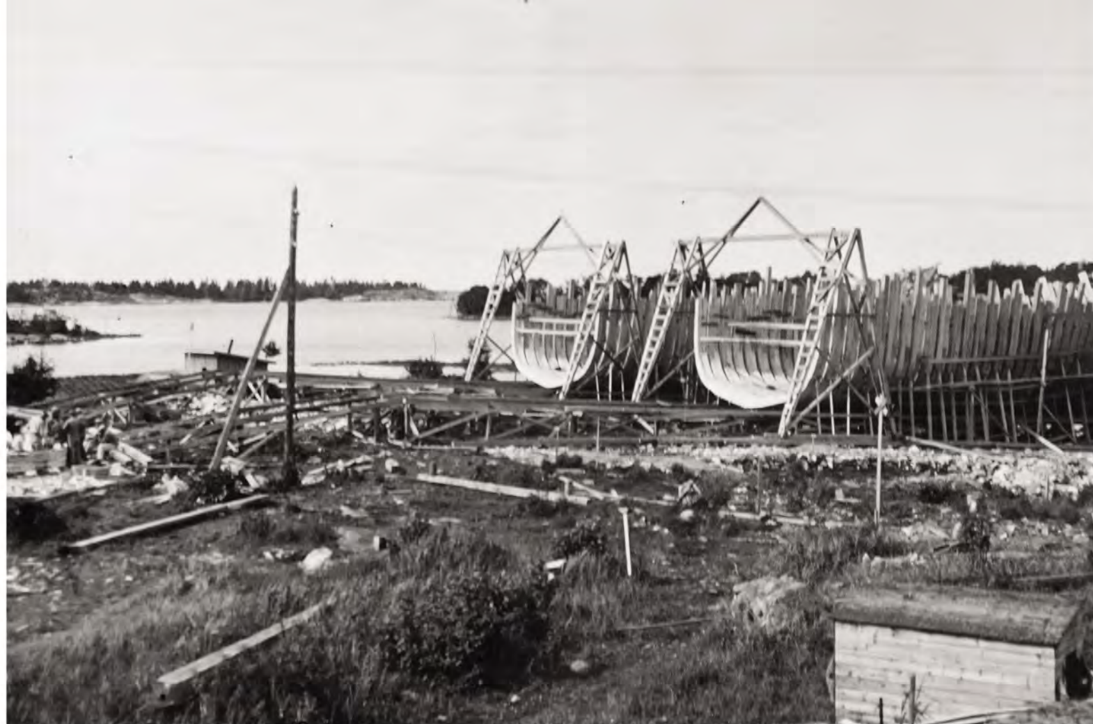
Корпуса на стапеле верфи Oy F. W. Hollming
