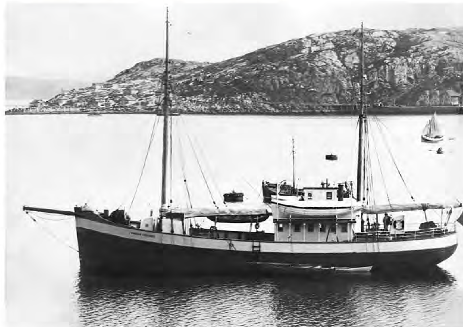
«Николай Книпович» — двухмачтовый бот (1928, верфь Gravdals Skibsbyggeri, Норвегия), длина 25,9 м, водоизмещение 100 т, паровая машина 120 л.с., основной корпус с усиленной дубовой ледовой обшивкой. Построен как специализированное научно-исследовательское судно по заказу Мурманской биологической станции
